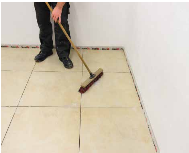
11 Die abgebrochenen Teile der Gewindelaschen werden aufgekehrt.
