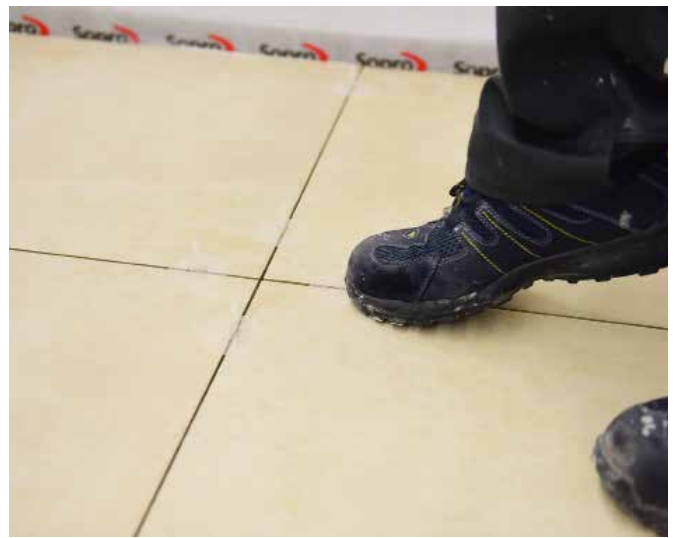
10 Gewindelasche wird abgebrochen. Option 2: Mit dem Schuh in Fugenrichtung.
