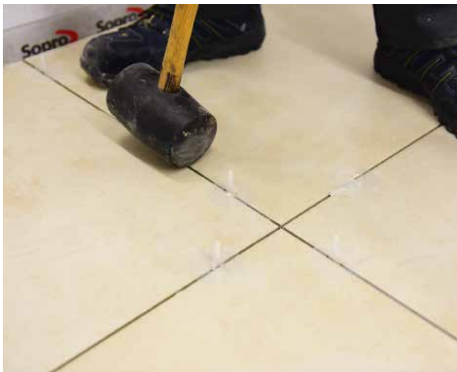
9 Gewindelasche wird abgebrochen. Option 1: Mit Gummihammer in Fugenrichtung.
